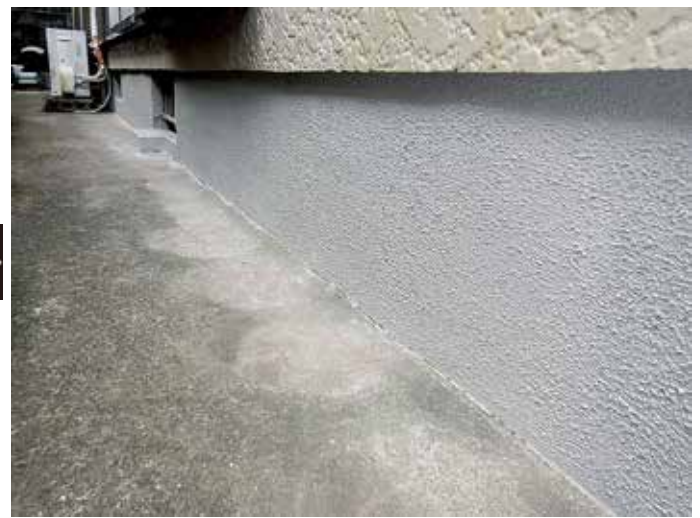
【ハウスシューズ施工後の基礎】
