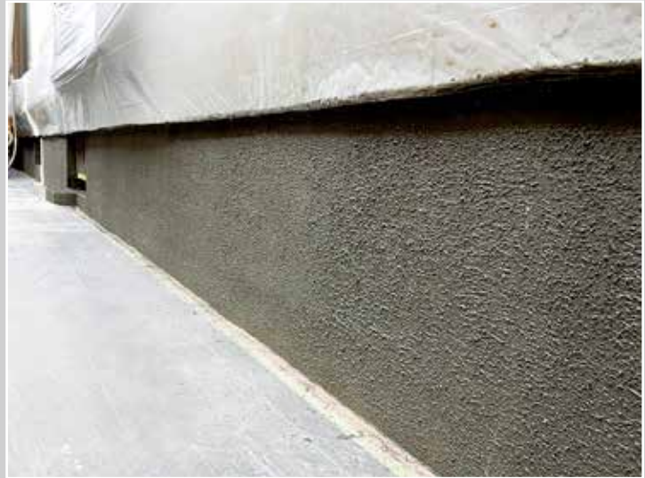
アンダーフィラー 102 塗布後
