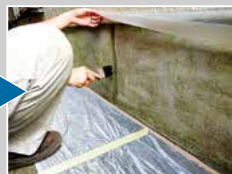
④下地調整（クラック補修等）
