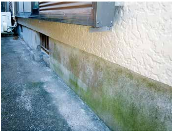
【ハウスシューズ施工前の基礎】
