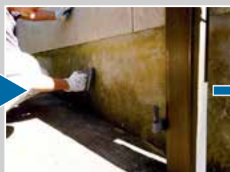
②施工面の清掃
