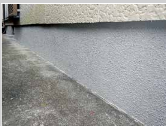
仕上がり（施工後）
