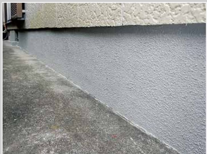
アンダーフィラー 102 塗布後
