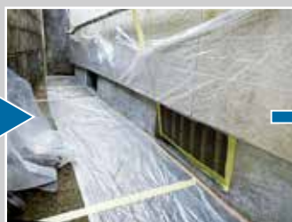
③施工範囲外の養生
