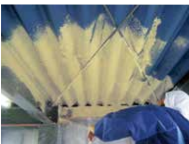
折板への吹付(天井断熱)
