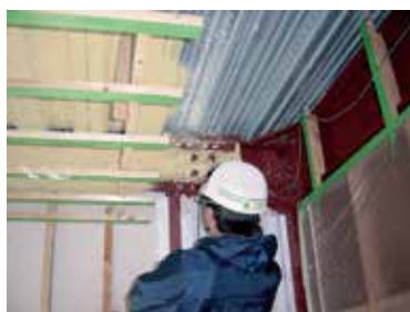
鉄骨梁への吹付(天井断熱)
